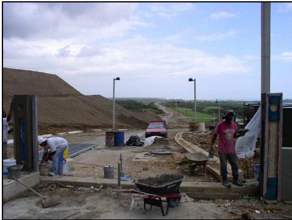
Figura 10. Vista hacia el norte del desarrollo dentro y en los alrededores del hábitat de E. m. granti . (Foto por Eduardo A. Ventosa.)
